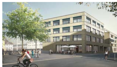
Bauliche Entwicklung «besonders gut gestaltet dichte Bahnhofüberbauung» Symbolbilder
