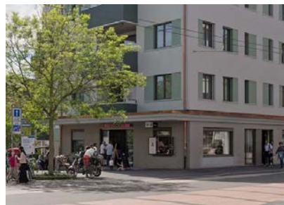
Röschibachplatz Zürich, Cafe in Ecklage
